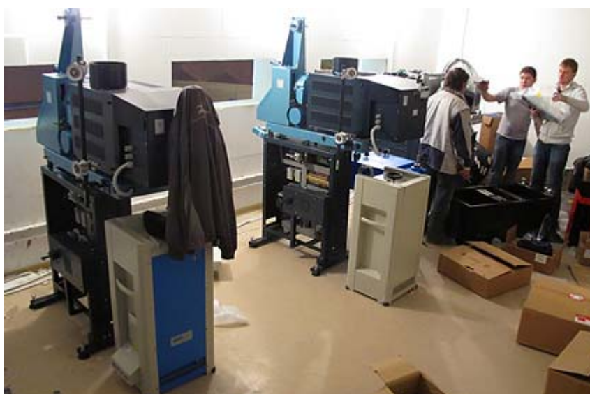
В главную аппаратную поставили две восьмикилловаттных «пленки» и одну «цифру» с 3D
