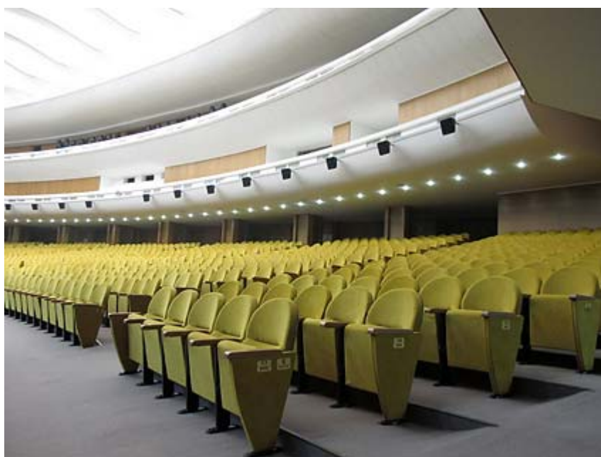
Монтаж трех десятков сурраундов на криволинейных поверхностях зала – задача, простая только на первый взгляд
