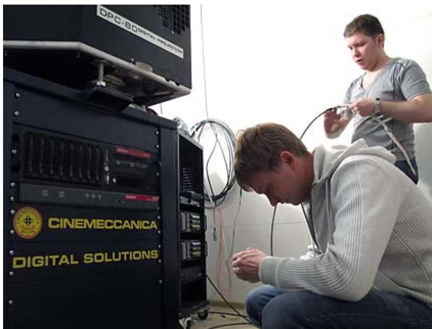
В пьедестале проектора предусмотрены места для сервера и вспомогательного оборудования
